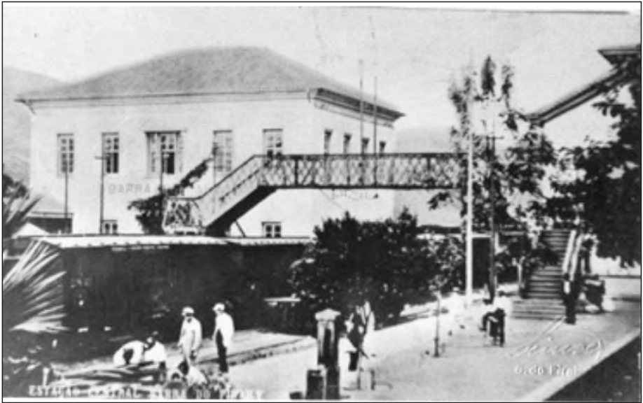
Mais tarde, como mostra a segunda foto, de 1910, foi construída uma passarela para ligar as duas plataformas existentes. Em 1912 esta passarela foi retirada após a construção, pelo engenheiro Martins Costa, de um subterrâneo em concreto armado. Martins Costa foi o primeiro técnico a empregar este sistema. Nesta época, estava na direção da Estrada de Ferro o engenheiro André Gustavo Paulo de Frontin e o subterrâneo recebeu o nome de Condessa de Frontin, em homenagem à esposa do consagrado engenheiro criador e construtor da linha dupla da Central.
